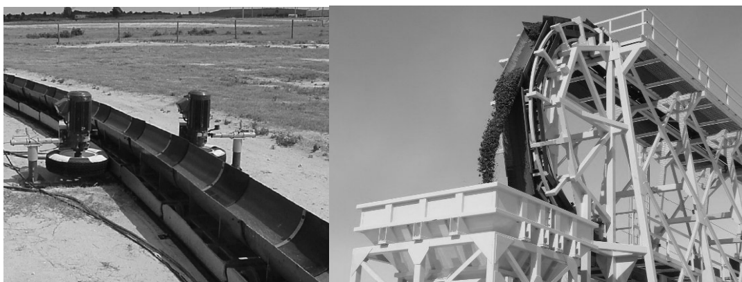
Рис. 8.3. Загальний вигляд конвеєрного потяга корпорації Rail-Veyor Technologies Global (Канада)
